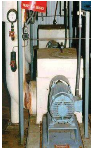
Hiệu suất kết hợp động cơ và bơm = 59%
